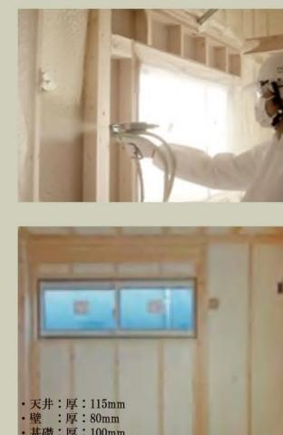
断熱性・機密性・吸音・遮音効果を備えた経年変化の少ない断熱材
